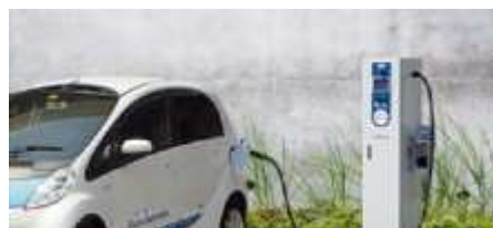
EV用急速充電器
